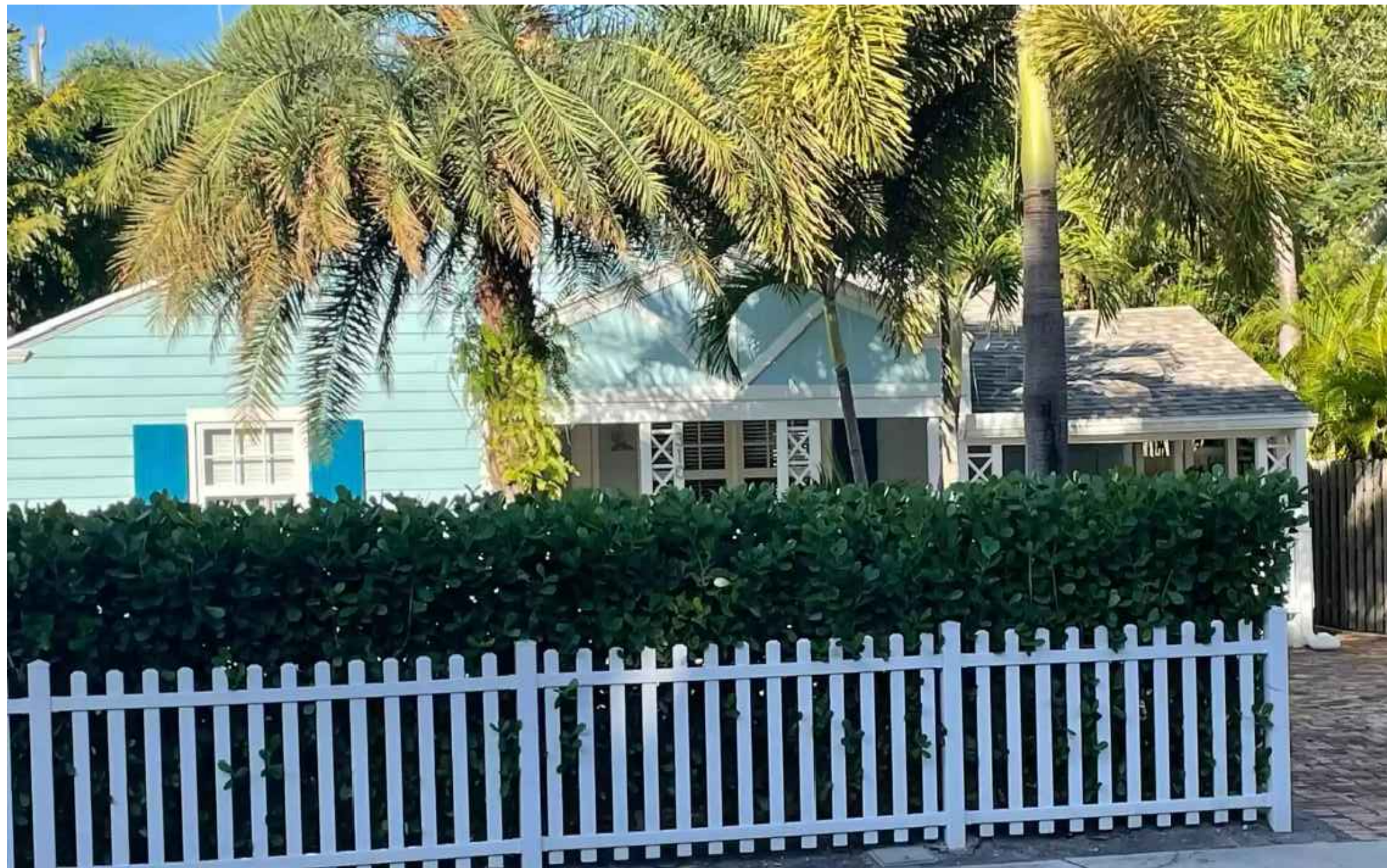
EAST ELEVATION- 310 NE IST AVE
